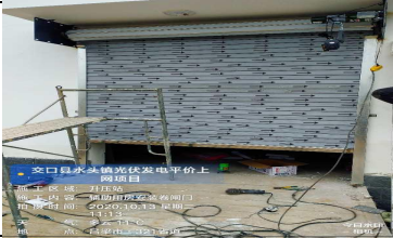
7、关键工序旁站照片：
