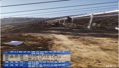
7、关键工序旁站照片：
