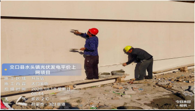
7、关键工序旁站照片：
