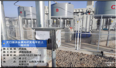
7、关键工序旁站照片：
