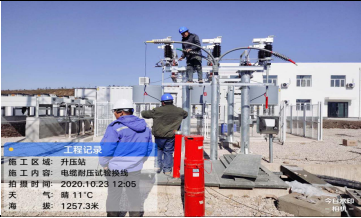
7、关键工序旁站照片：
