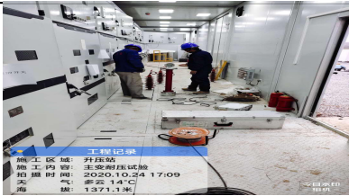
7、关键工序旁站照片：
