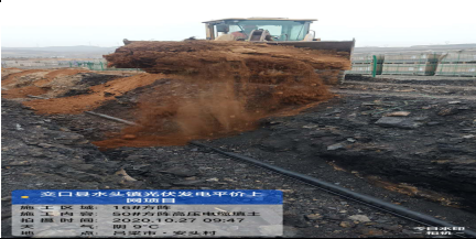
7、关键工序旁站照片：
