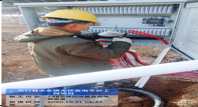
7、关键工序旁站照片：
