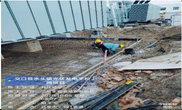
7、关键工序旁站照片：
