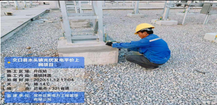
7、关键工序旁站照片：
