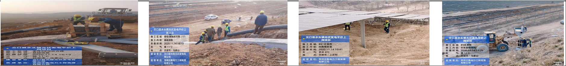
7、关键工序旁站照片：
