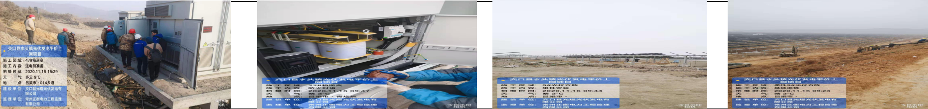
7、关键工序旁站照片：
