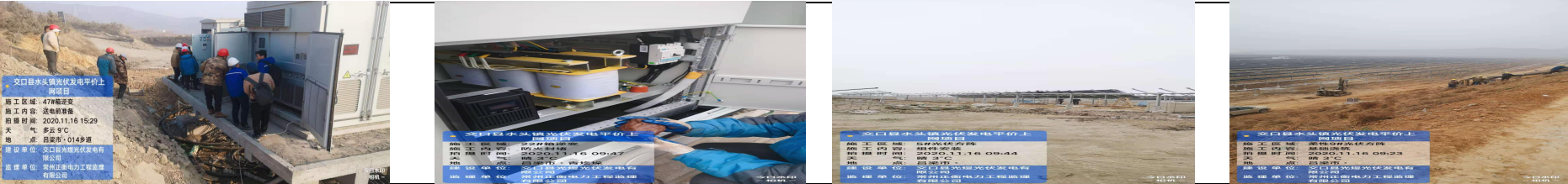
7、关键工序旁站照片：
