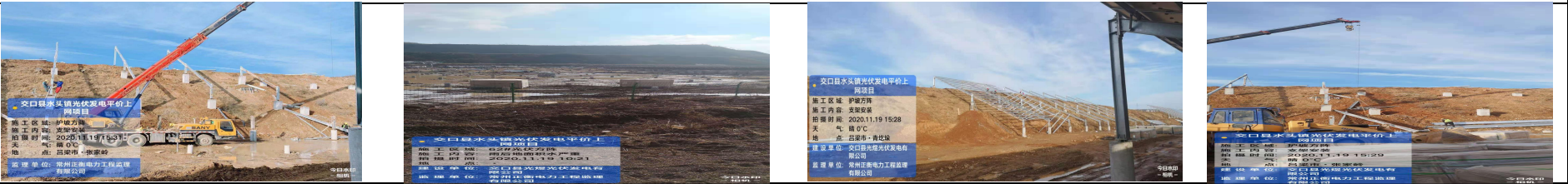
7、关键工序旁站照片：
