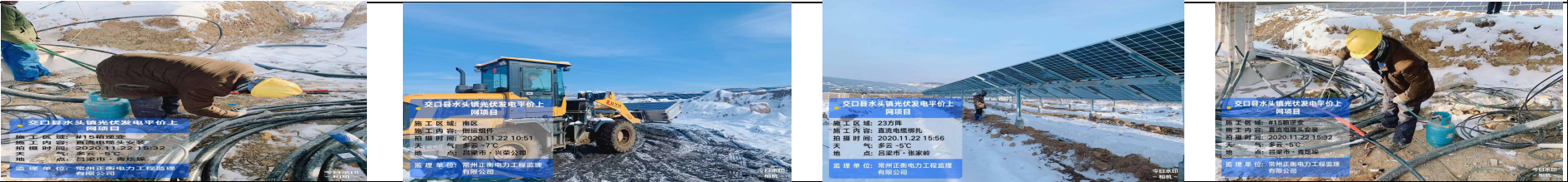
7、关键工序旁站照片：
