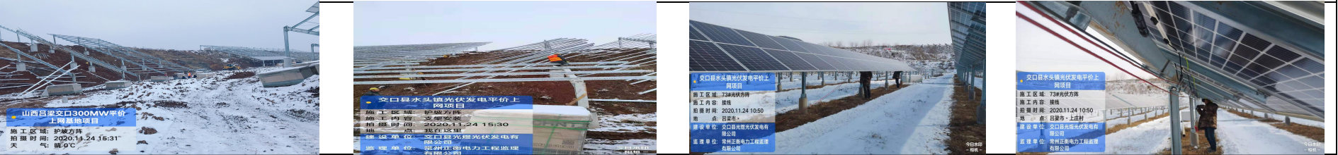
7、关键工序旁站照片：
