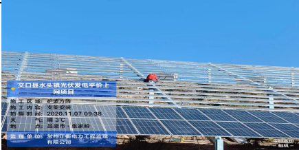
7、关键工序旁站照片：
