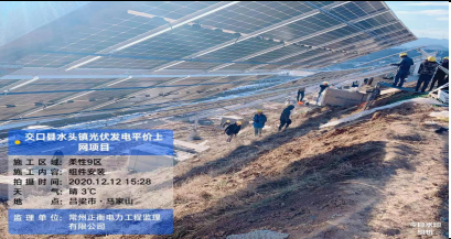
7、关键工序旁站照片：
