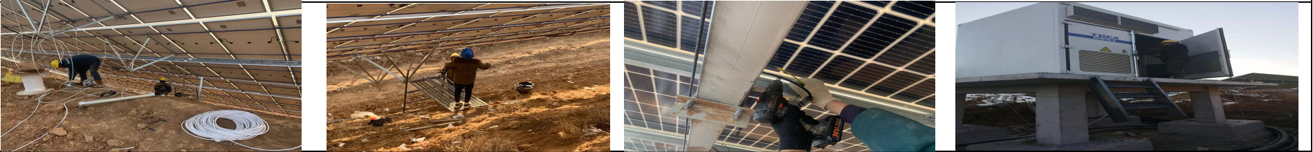
7、关键工序旁站照片：
