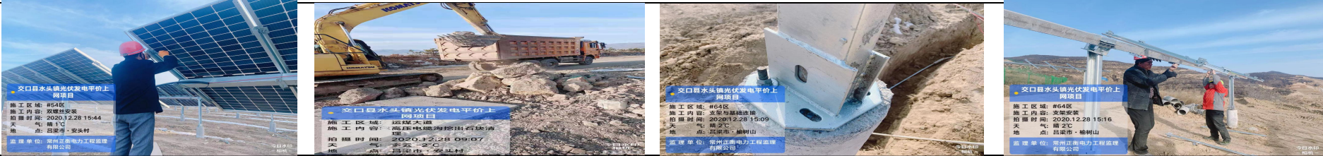
7、关键工序旁站照片：
