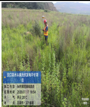
7、关键工序旁站照片：
