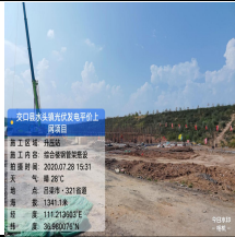
7、关键工序旁站照片：
