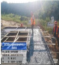
7、关键工序旁站照片：
