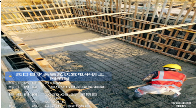
7、关键工序旁站照片：
