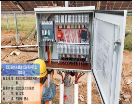
7、关键工序旁站照片：
