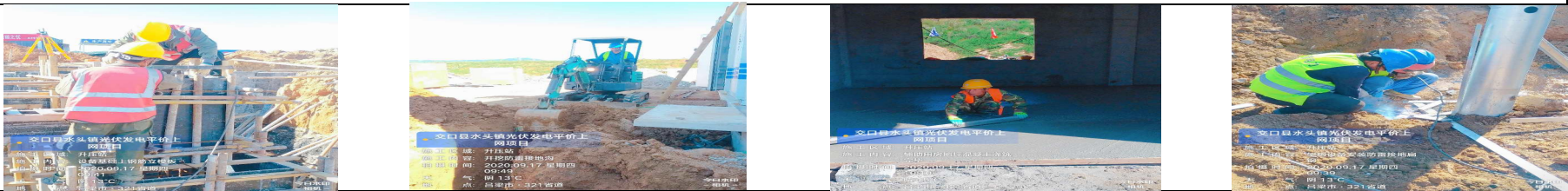
7、关键工序旁站照片：
