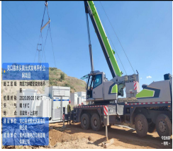
7、关键工序旁站照片：
