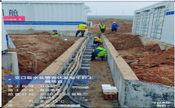
7、关键工序旁站照片：
