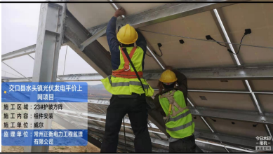
7、关键工序旁站照片：
