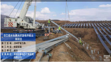
7、关键工序旁站照片：
