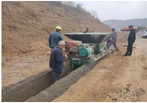
7、关键工序旁站照片：
