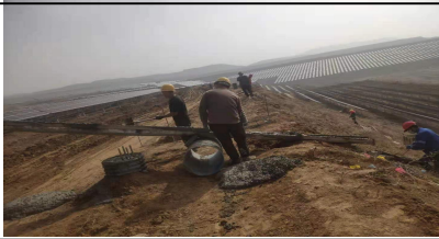
7、关键工序旁站照片：
