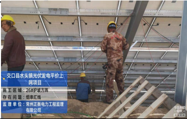
7、关键工序旁站照片：
