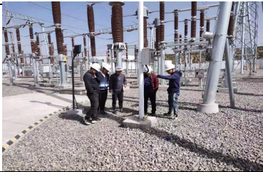
7、关键工序旁站照片：
