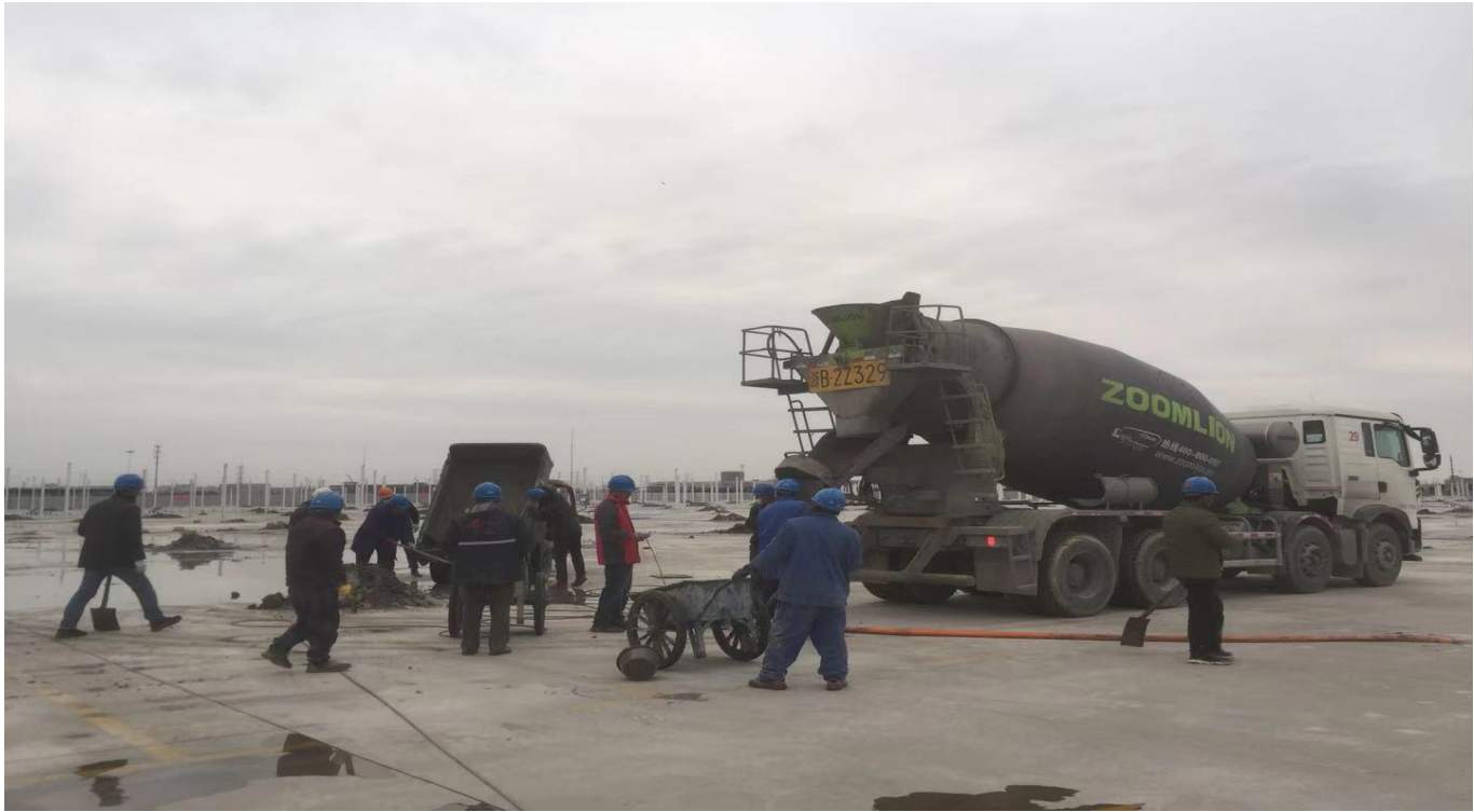
现场施工照片
