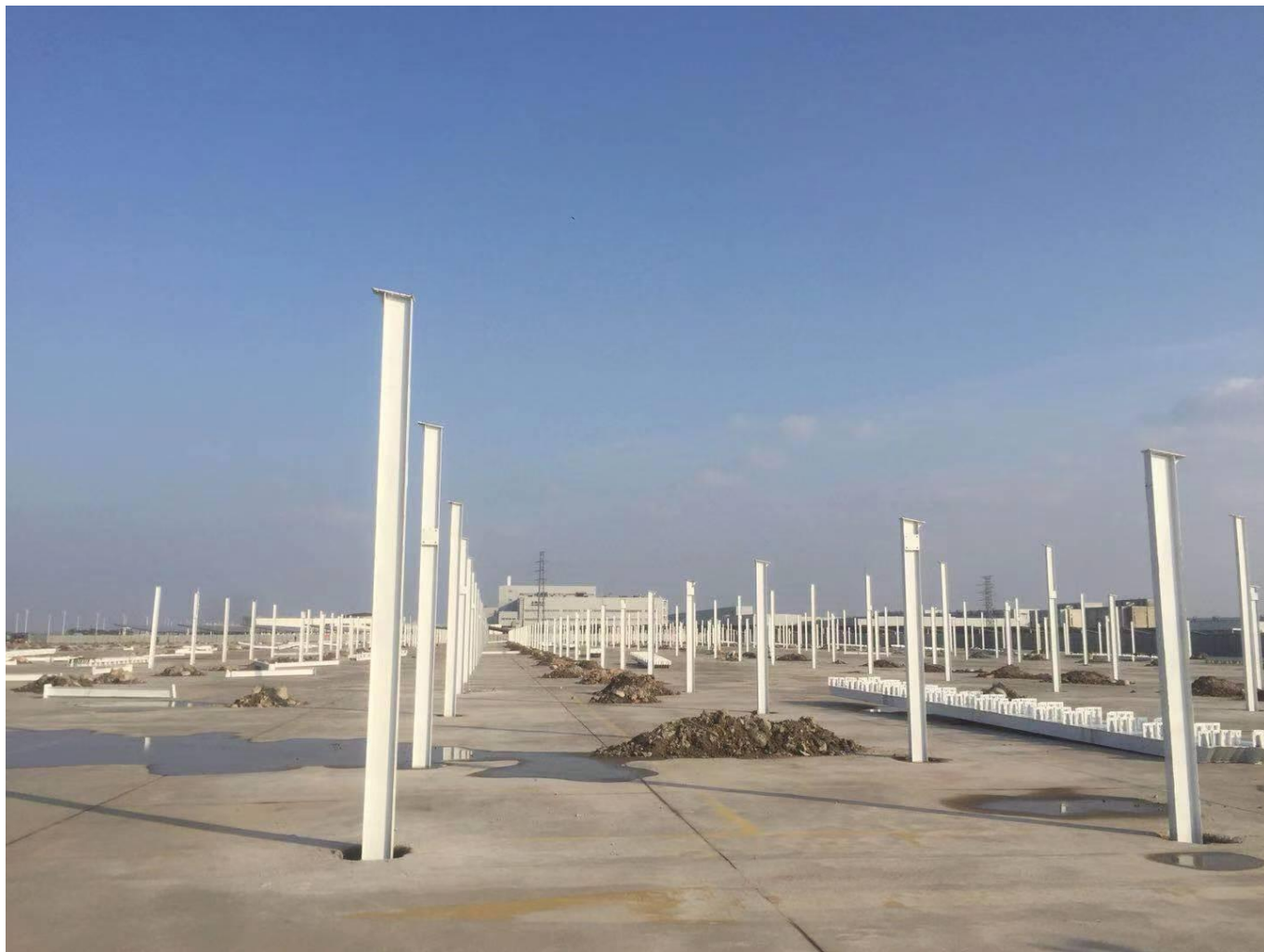
现场施工照片
