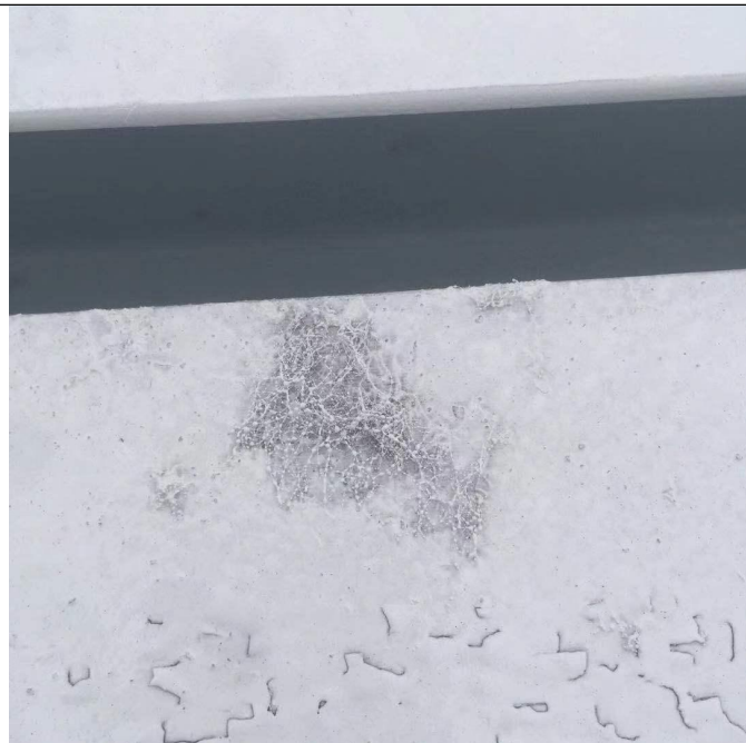
钢结构底部锈蚀
