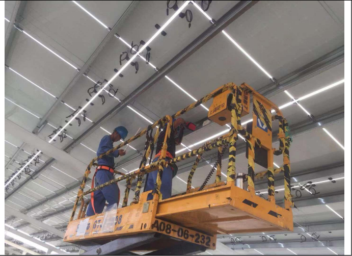
照明管线安装
