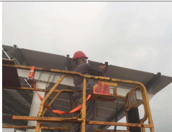
组件 1*4mm 2 电缆接头制作
