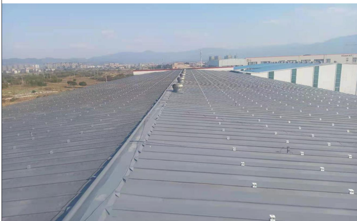
图 2：6#屋面夹具安装完成情况
