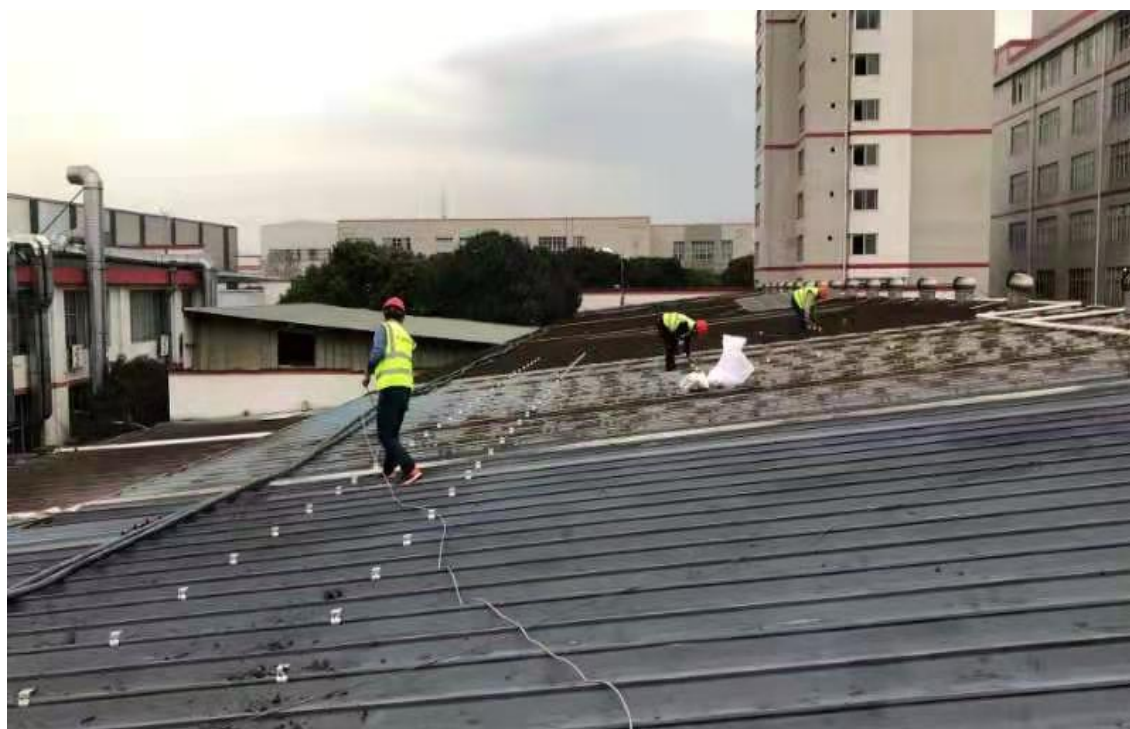
图 1：屋面垃圾清理、夹具安装
