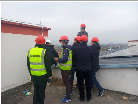
图 1：初检现场照片
