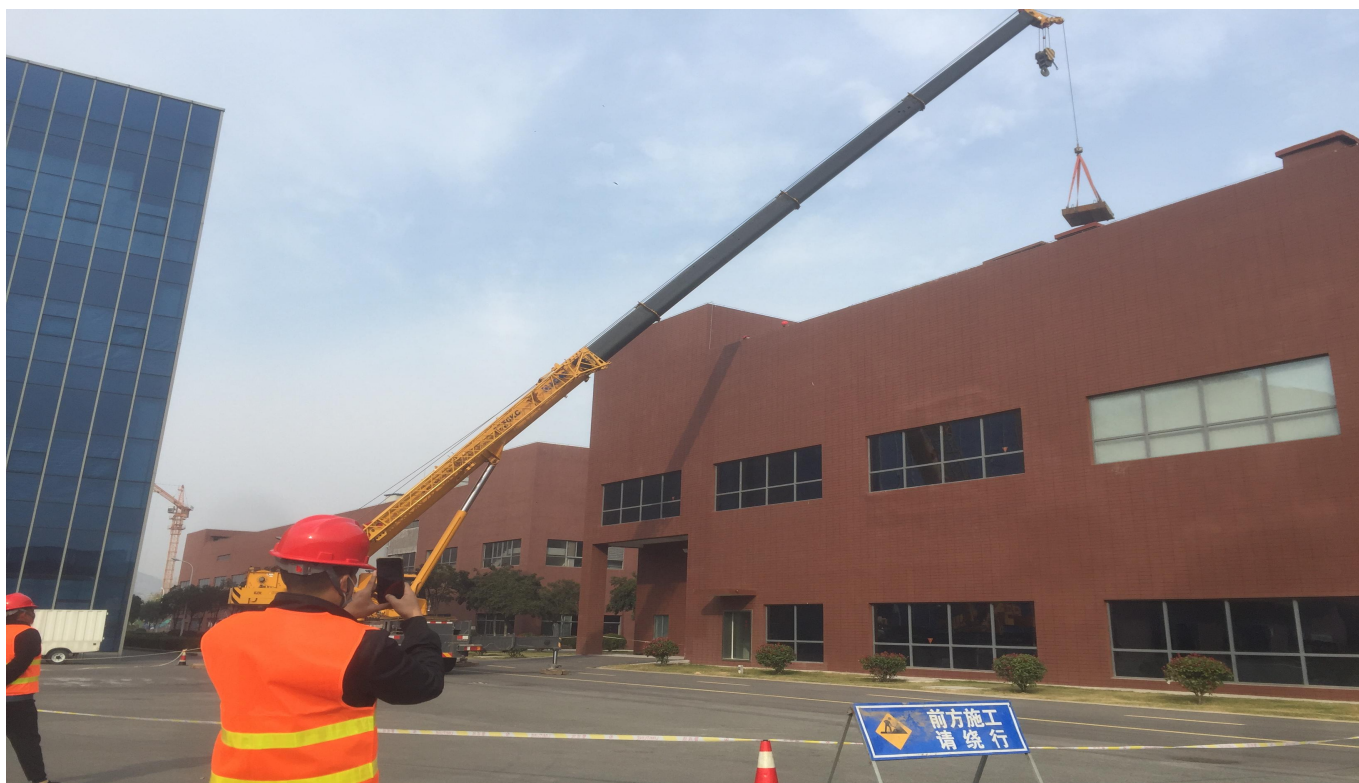
1、综合制剂车间吊装作业许可
