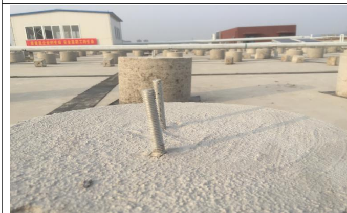
9、成品保护不力 U 型螺栓引出部分变形
