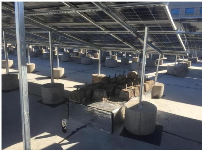
9、间距过大致拉筋卡片无法正常安装
