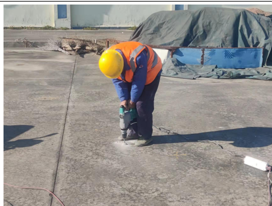
地脚螺栓孔位清孔
