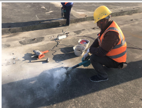
地脚螺栓孔位清孔
