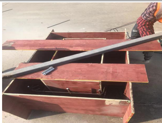
汇流柜基础模板安装
