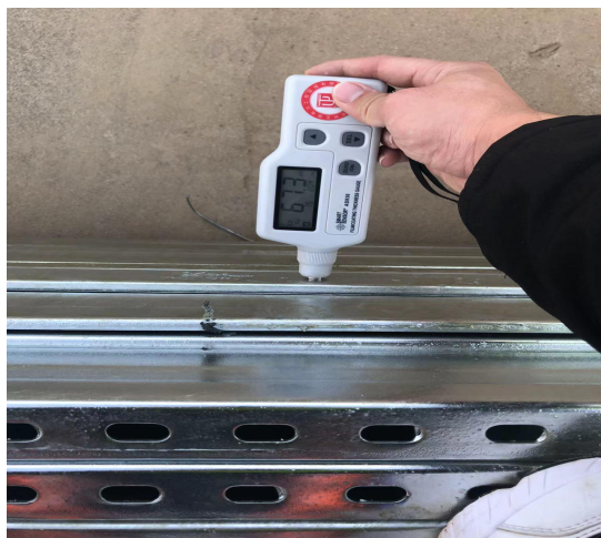
进场支架检查
