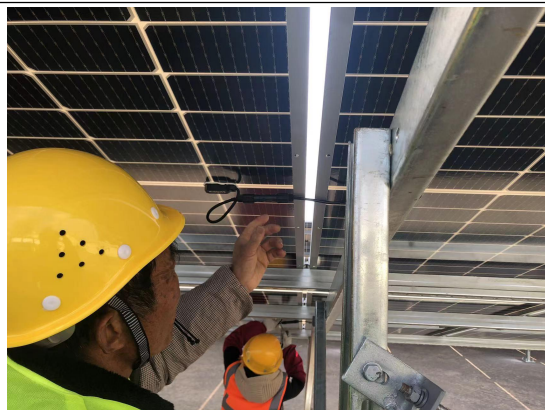
中边压缝隙不符合要求
