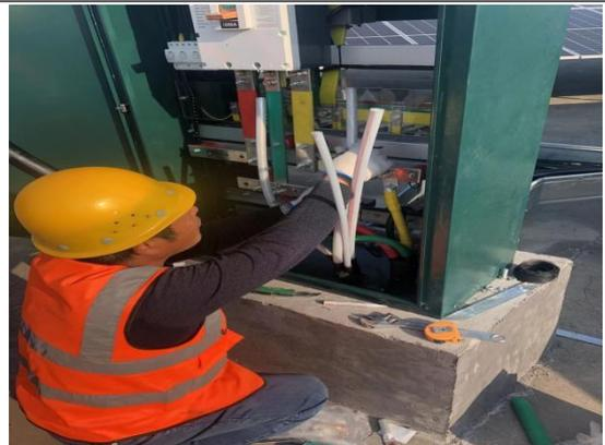
电缆安装，穿孔位置电缆皮包裹防护
