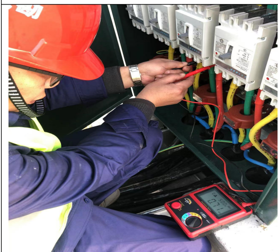
电缆相间绝缘测量
