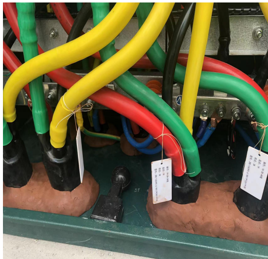
汇流柜电缆悬挂标识牌、防火封堵
