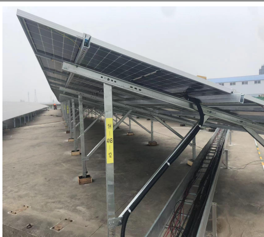
电缆转角处防护
